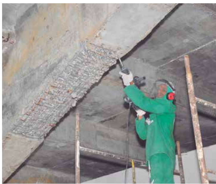
O trabalho de impermeabilização já vem sendo feito há vários dias
