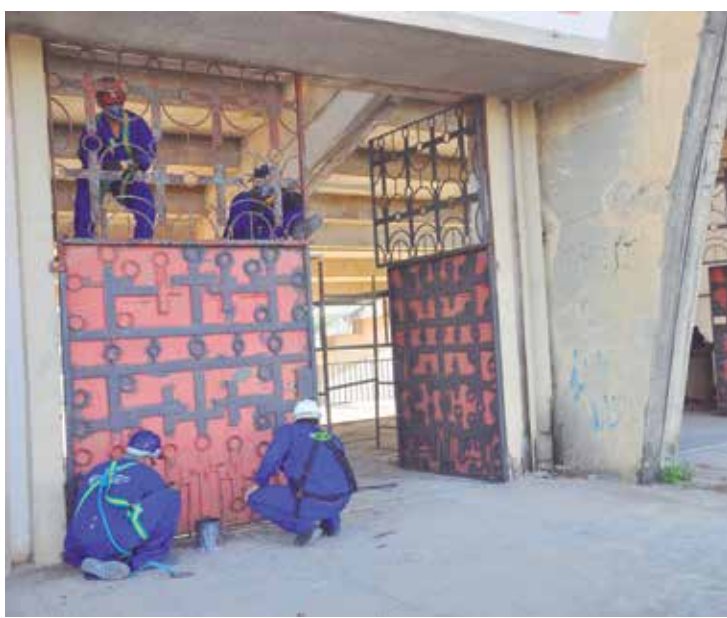
Entrada da arquibancada sol já sendo revitalizada pelos operários
