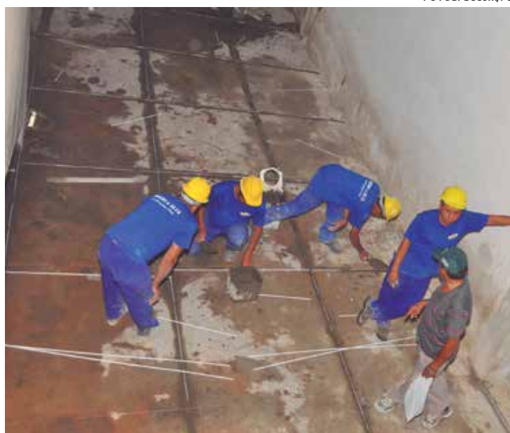
Operários trabalham na parte interna no lado da arquibancada sol
