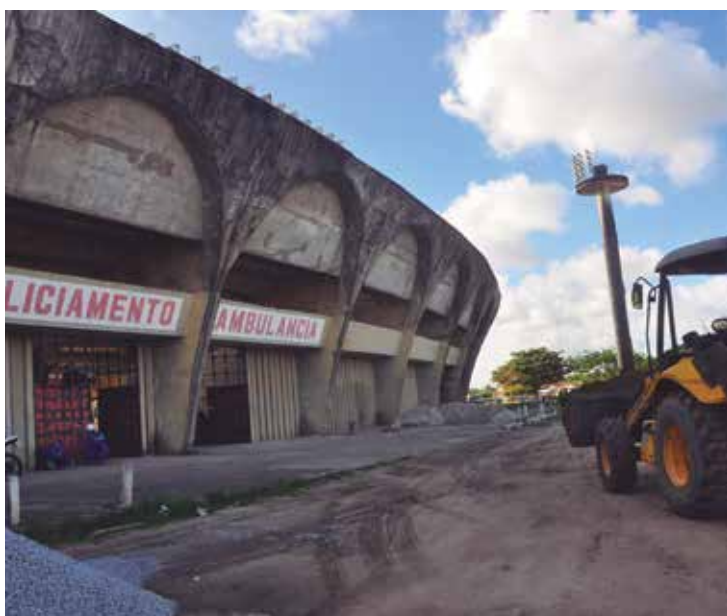
Fora do Estádio já existe trabalho para reurbanização da área
